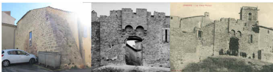
Figure 52 : Vestiges des remparts & ancienne porte fortifiée (Source Ministère de la Culture/base Mérimée)
