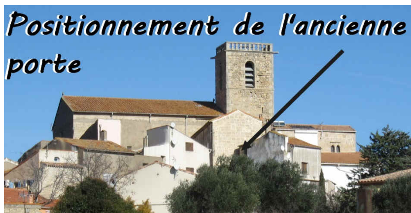
Figure 53 : Positionnement de l'ancienne porte (Source : AMAE)
