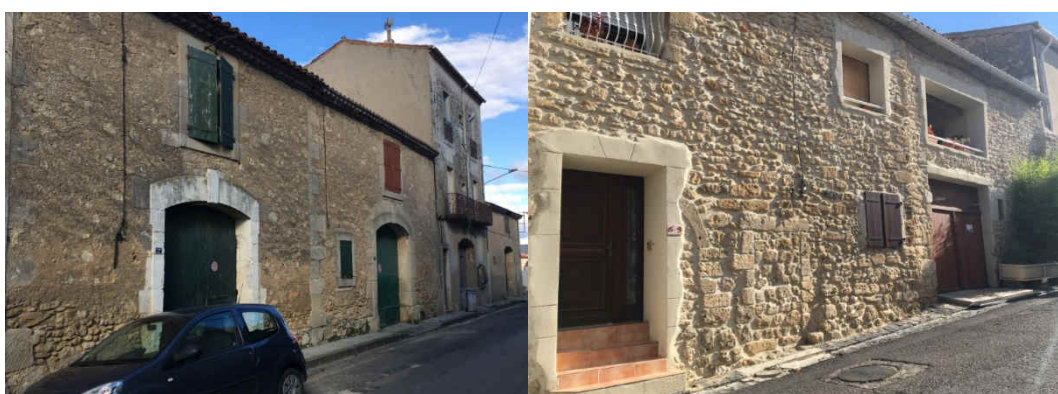
Figure 68 : Ensemble de remises avec détails typiques, les grandes entrées voutées (rue de paradis) – Exemple de rénovation respectueuse en gardant visibles les anciennes ouvertures (à droite de la porte) (rue de l'égalité) (Source : AMAE)
